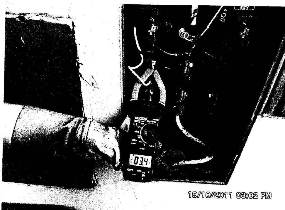
Toma de carga conexión indebida Fase R – cable blanco
