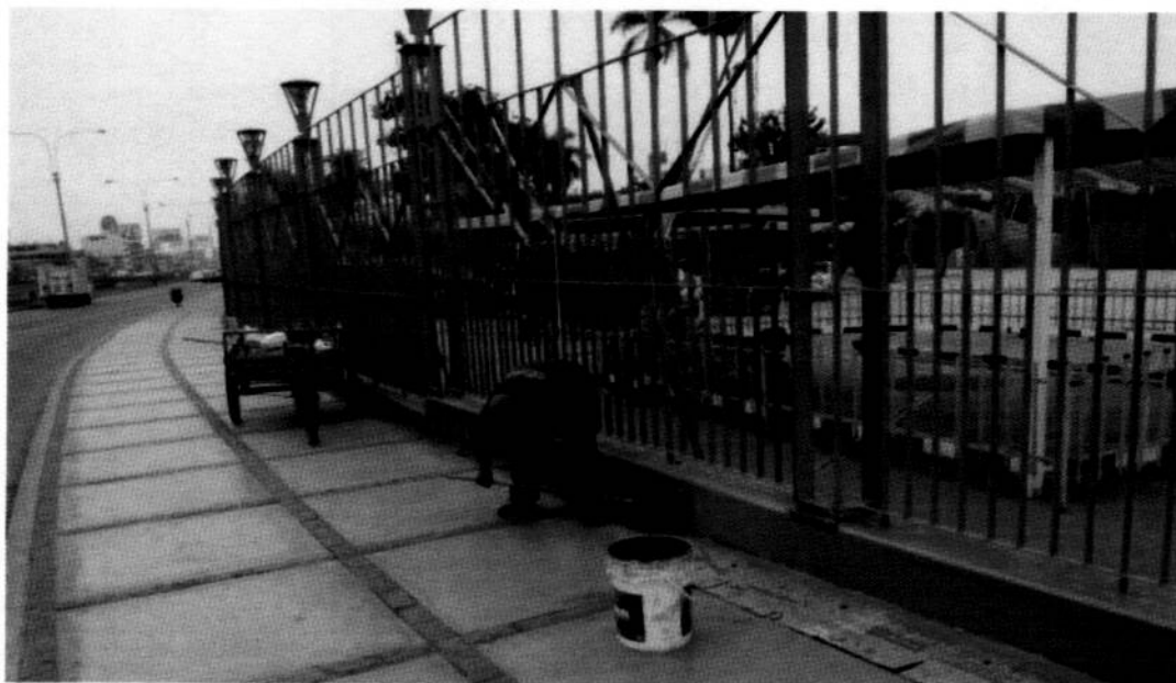
MANTENIMIENTO Y PINTADO DEL CERCO PERIMÉTRICO
