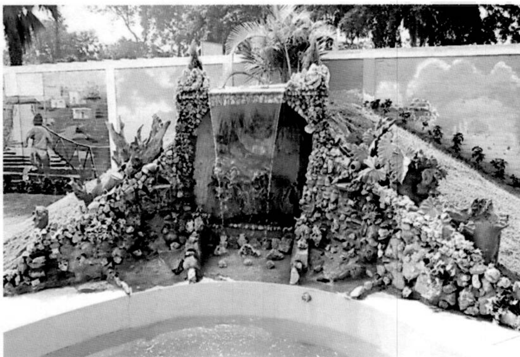
MANTENIMIENTO DE CASCADA
