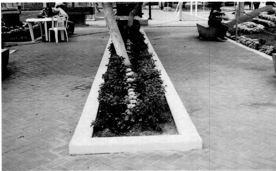
MANTENIMIENTO Y PINTADO DE SARDINELES
