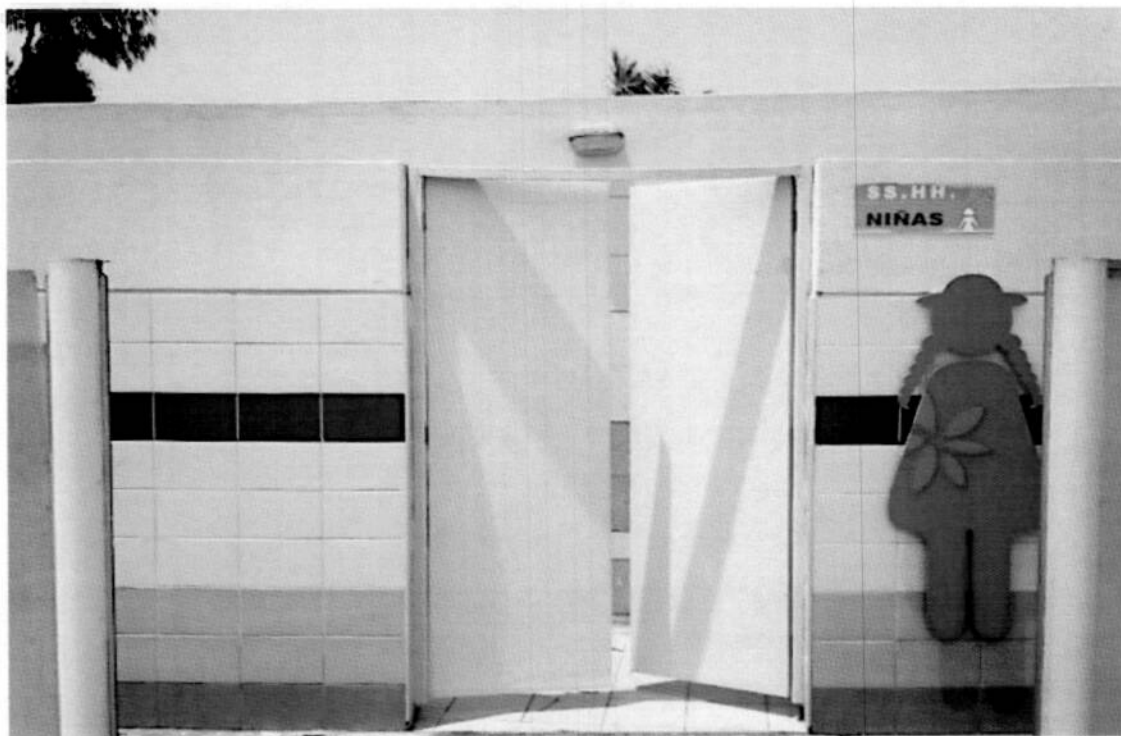
PINTADO DE LOS AMBIENTES DE LOS VESTUARIOS Y SS.HH. DEL COMPLEJO DE PISCINA
