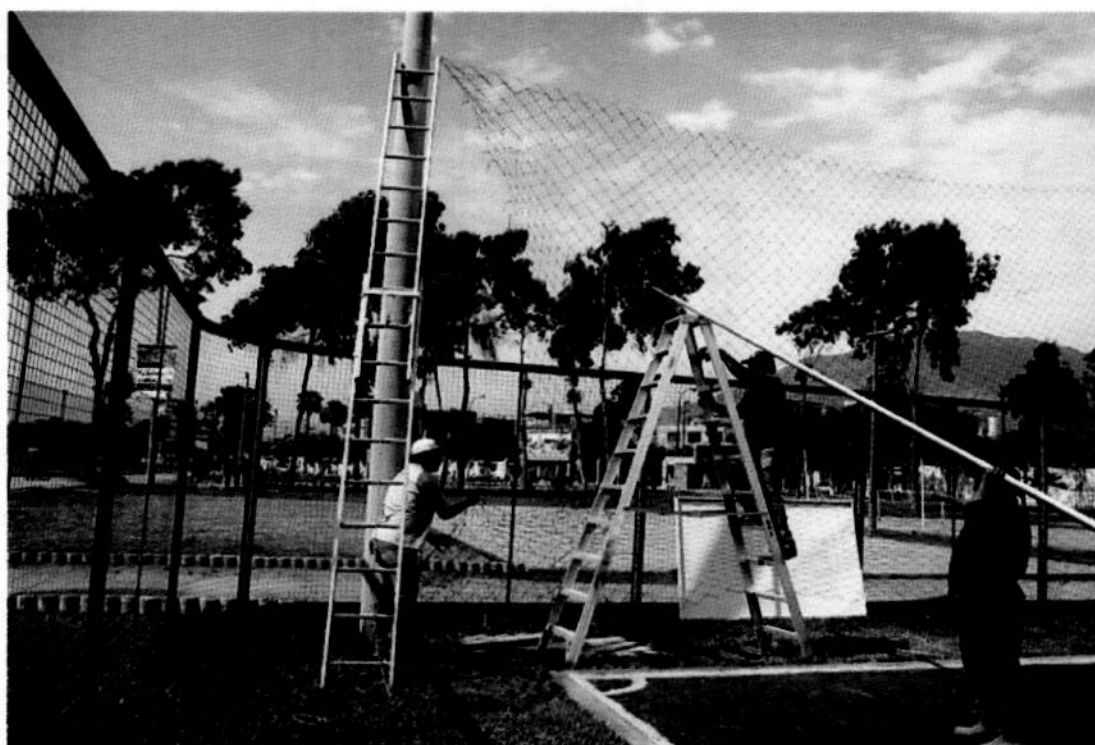
COLOCACION DE MALLAS EN LA ZONA DEL CAMPO SISNTETICO
