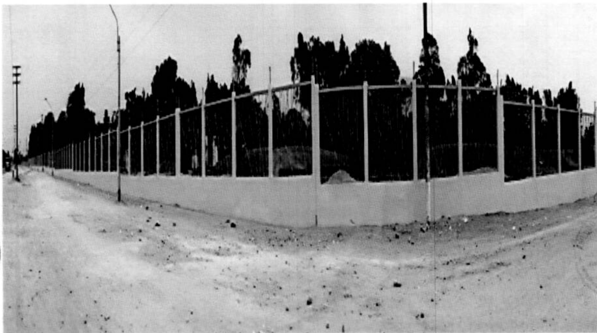
MANTENIMIENTO DEL CERCO PERIMÉTRICO
