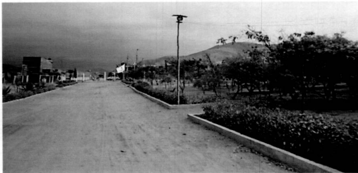
INSTALACION DE REFLECTORES PARA SEGURIDAD INTERNA
