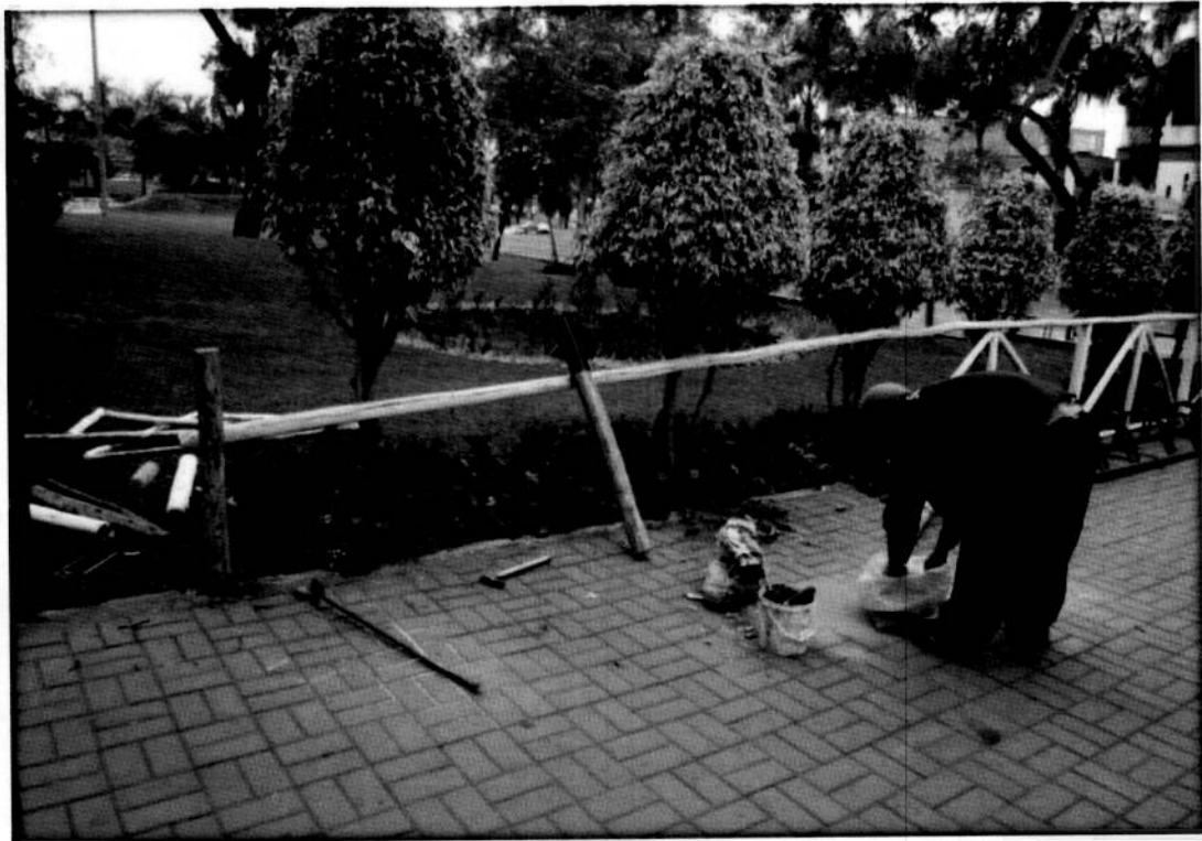
REPARACIÓN DE CERCO DE PALOS (ZONA DE INGRESO ADMINISTRACIÓN)
