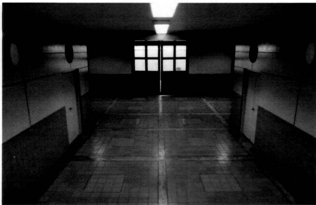
MANTENIMIENTO Y PINTADO DE LOS CAMERINOS DEL ANFITEATRO
